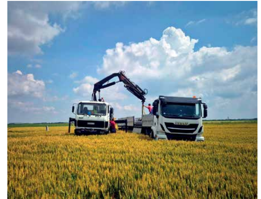
Истовар челично-решеткасте конструкције за двоструки далековод на траси увођења ДВ бр. 450 у будућу ТС Београд 50 у Добановцима
