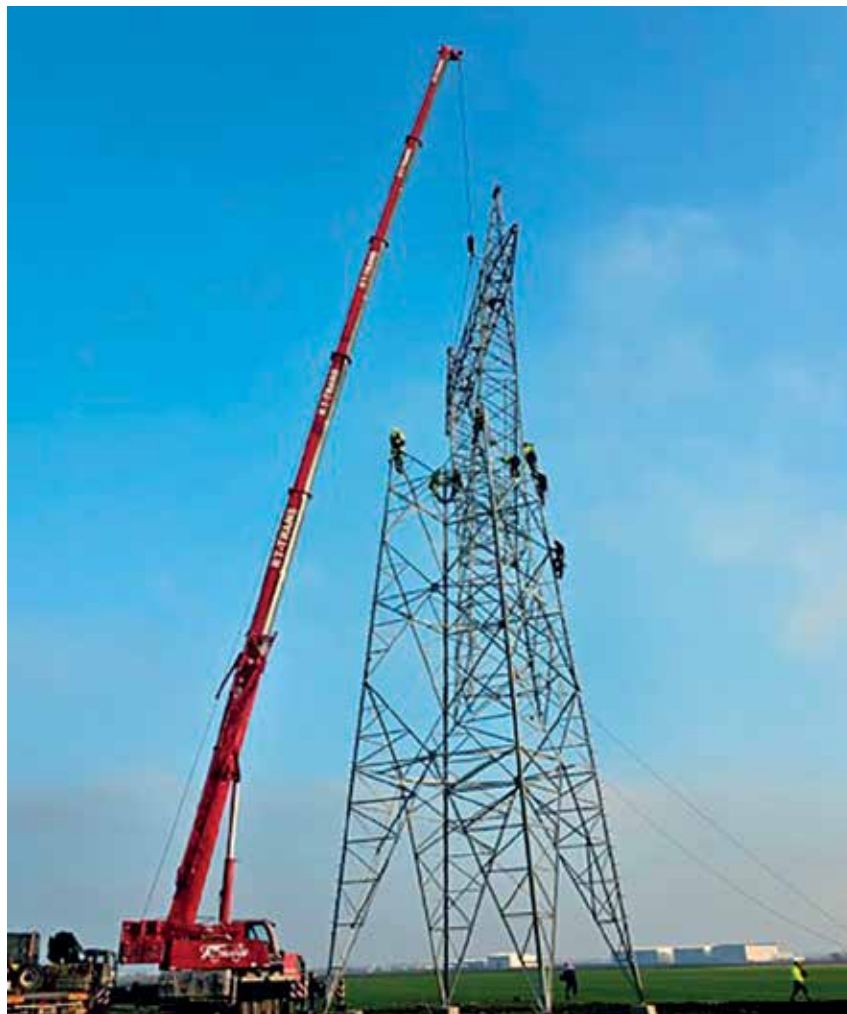
Подизање и монтажа челично-решеткастих „У“ стубова на траси увођења ДВ бр. 450 у будућу ТС Београд 50 у Добановцима
