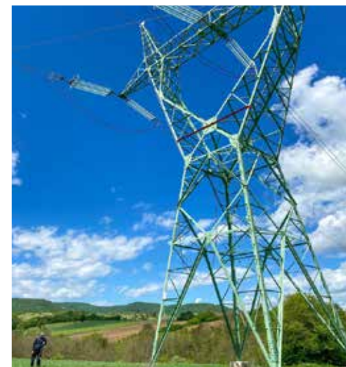
Мерење буке на надземном 400 kV воду ЕМС АД
