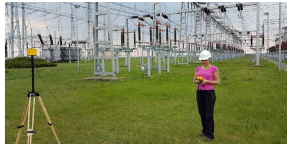
Мерење буке у трансформаторској станици EMC АД
