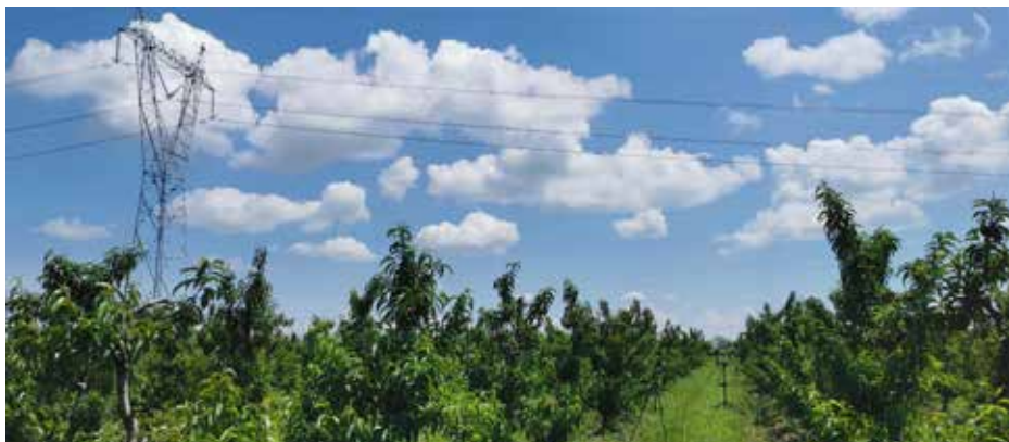
Мерење буке на једносистемском 400 kV надземном воду ЕМС АД
