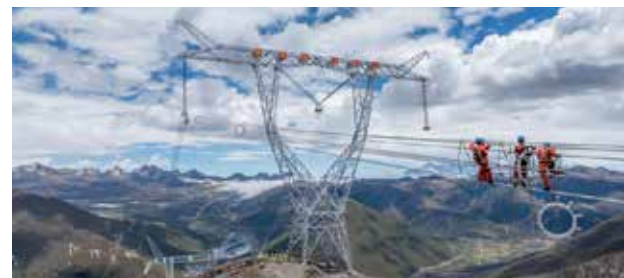
Слика 2: Пројекат наизменичног УВН преноса Сечуан–Чунгџинг је национални приоритет. На фотографији радници постављају проводнике. (Интернет извор)
