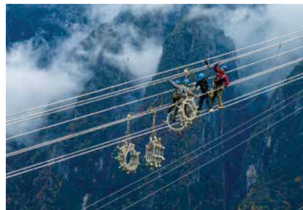
Слика 4: Код хидроелектране Сјаотианду у граду Кангџинг, радници постављају растојнике на УВН воду Сечуан–Чунгџинг. (Интернет извор)
