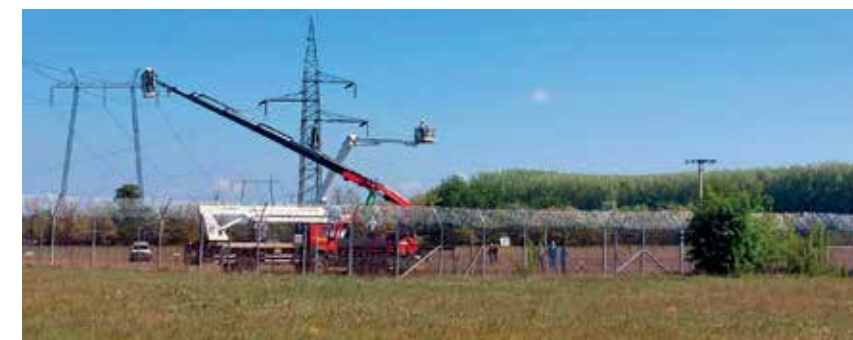
Први стуб на мађарској страни - у позадини се виде ДВ 400 kV бр. 454 ТС Суботица 3 – мађарска граница – ТС Шандорфалва и средњенапонски далековод
