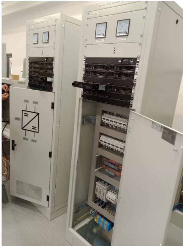
Ормани система за непрекидно напајање 48 VDC (DC/DC претварачи 220/48 VDC)
