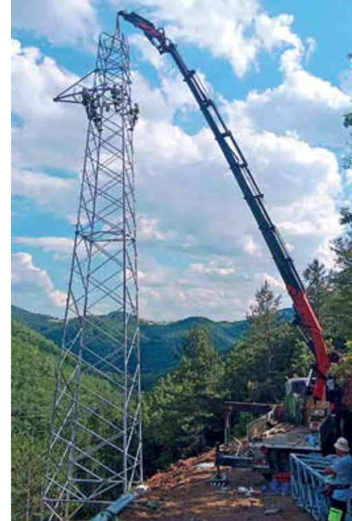
Изградња далековода од ТС Краљево 3 до ТС Нови Пазар 1
