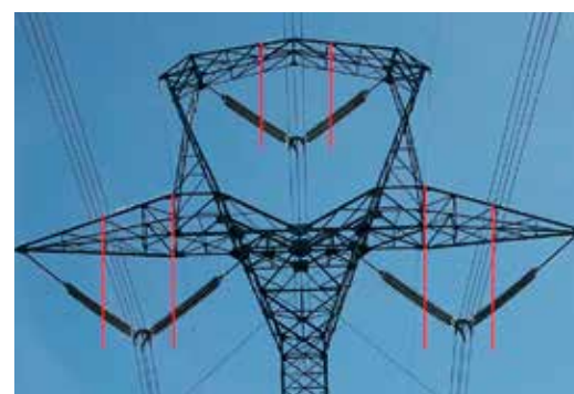
Конструкција за одвраћање птица штити отприлике половину изолаторског ланца
