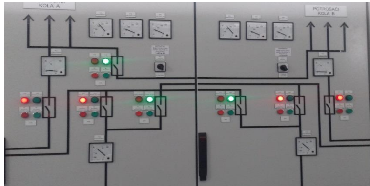
Ормани главног развода једносмерног напона сопствене потрошње у ТС 400/220/110 kV Сремска Митровица 2
