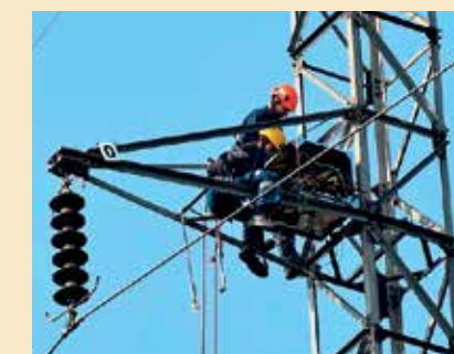
Постављање алуминијумске кутије за гнезђење степског сокола на далеководу типа „Јела“
