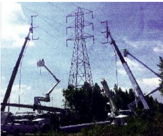
Тимови користе земну роботичку технологију за рад под напоном на компонентама преносног система. Фотографију је уступила фирма Quanta Services
