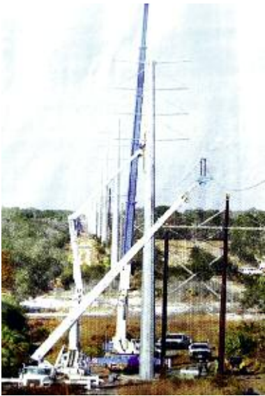
Током обнове вода у дужини од 21 миље, коришћена је земна роботичка рука са једном тачком додира за пребацивање проводника под напоном са старе стубне конструкције Н рама на двосистемску цевну стубну конструкцију. Фотографија - Quanta Services
