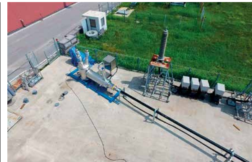
Типско испитивање 23 kV HTS кабл у КЕПЦО-овој испитној лабораторији Гошанг
