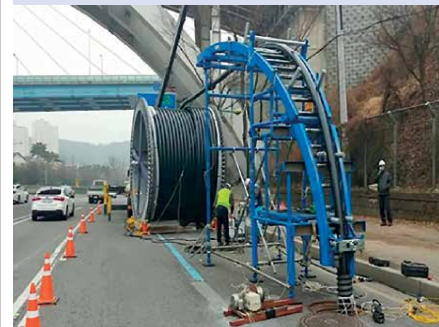
Радови на постављању кабла
