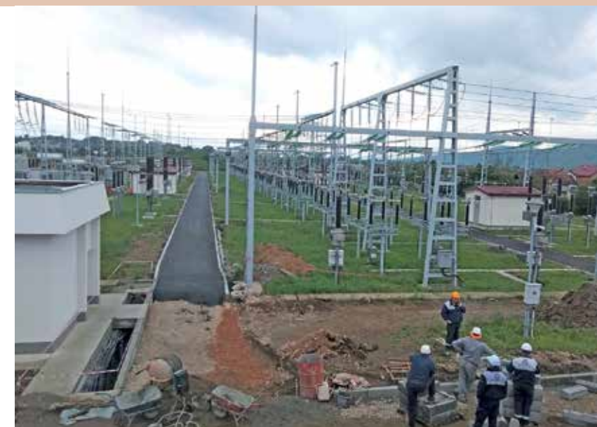
Обављена је адаптација дванаест сабирничких и три излазна расстављача 220 kV
