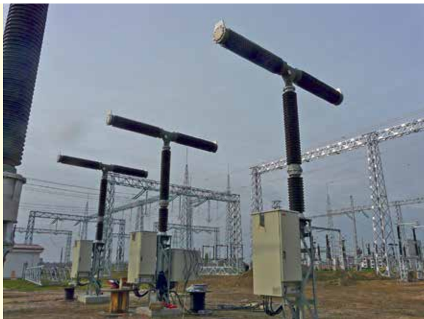
Реконструкција ТС Србобран
