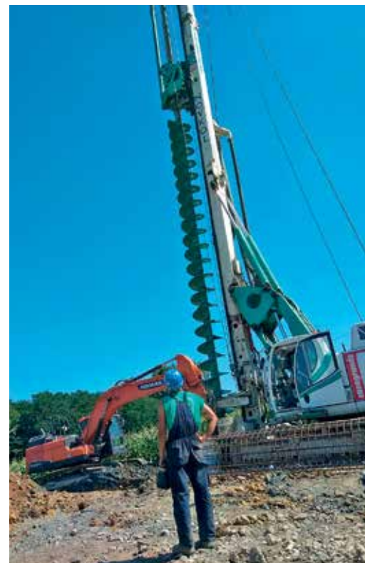
Радови на изградњи шипова
