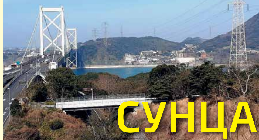
Интерконекција између острва Kyushu, односно Kyushu Electric Power Company са другим електроенергетским компанијама Јапана, једним двосистемским 500 kV надземним водом, дужине 1.200 m.
