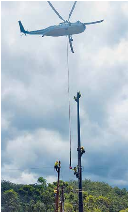
Хеликоптер Сикорски помаже у градњи новог 138-kV стуба у удаљеној области
