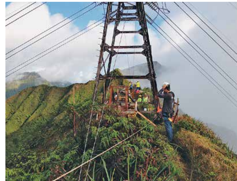
Тимови на изградњи припремају се за замену старих стубних конструкција на гребену у удаљеним областима
