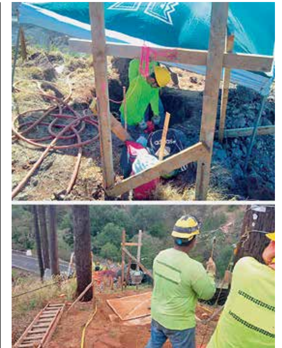
Тимови често морају ручно да копају темеље а потом да транспортују остатке са локације помоћу ручне жичаре са корпом
