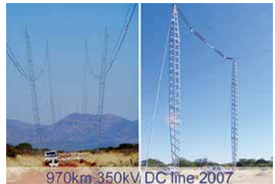
Варијанте стубне конструкција са ланчаницама за 350kV ВН ЈС преносни вод дужине 970 км, који је изграђен 2007. године
