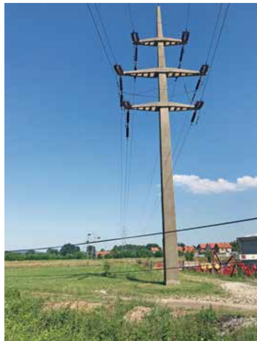
Стари бетонски стубови ће бити замењени новим челично-решеткастим
