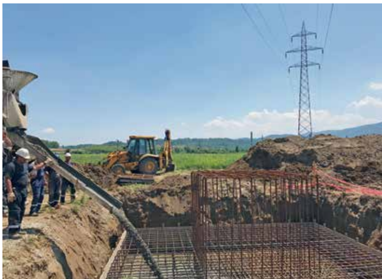
У току је извођење радова на изливању темеља за стубове у близини ТС Лозница
