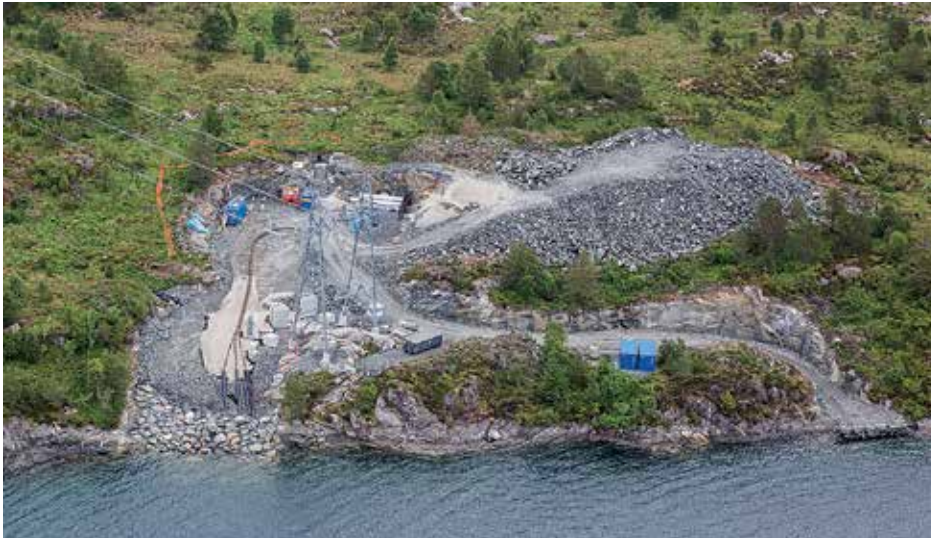
Фотографски приказ локације на самој обали у Мјасундету (Mjåsundet), Линдас, као и бетонске завршне конструкције
