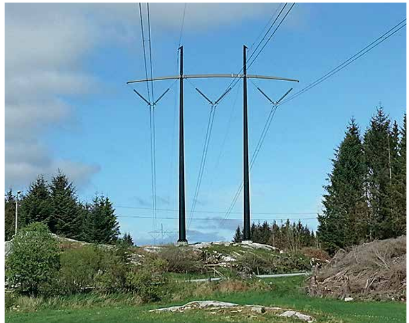
Преносни стубови за копнене делове 420 kV далековода пројектовани су за два проводника у спону
