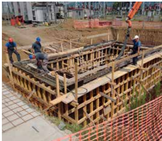
Изградња уљне јаме
