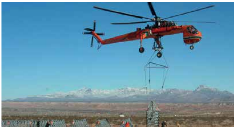
Употреба хеликоптера за пренос тешких терета при монтажи 160 стубова за пренос електричне енергије на висинама 3-4.000 метара планинског ланца Пир Панџал
