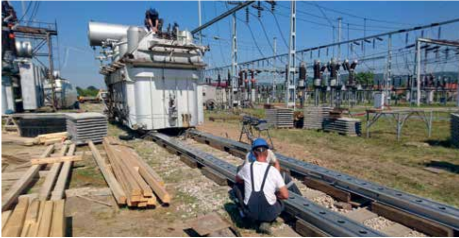
Извожење старог трафоа Т1 из постројења
