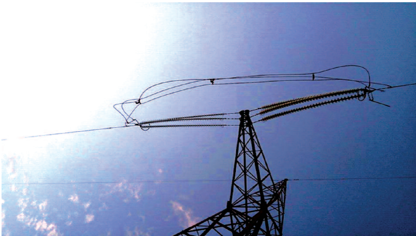
Ваздушни напади су изазвали велико оштећење на овом 400 kV преносном воду
