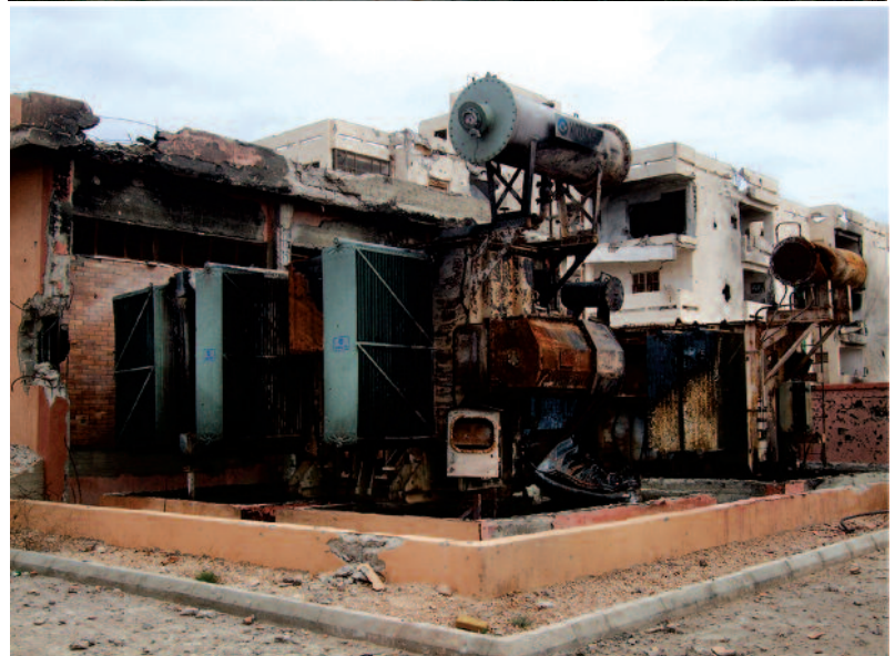
Значајна оштећења на 11 kV дистрибутивном трансформатору и 66 kV трафостаници пружају увид у обим разарања које је резултат догађаја који су саставни део актуелног грађанског рата у Либији
