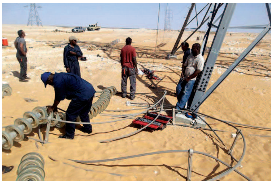
Услед недостатка материјала, радници морају да на свакој локацији спасавају све што могу од опреме. У овом случају, демонтажу оштећене проводнике и изолаторе са 220 kV преносног вода
