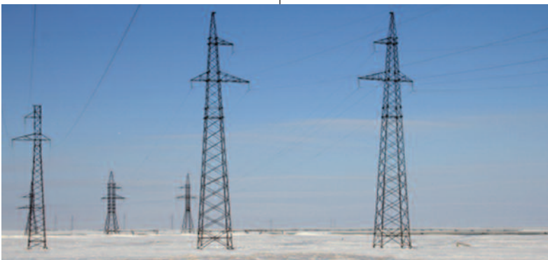
АД Тумененерго спроводи ремонт на 110kV преносним водовима током идеалних услова у Аутономној области Јамал
