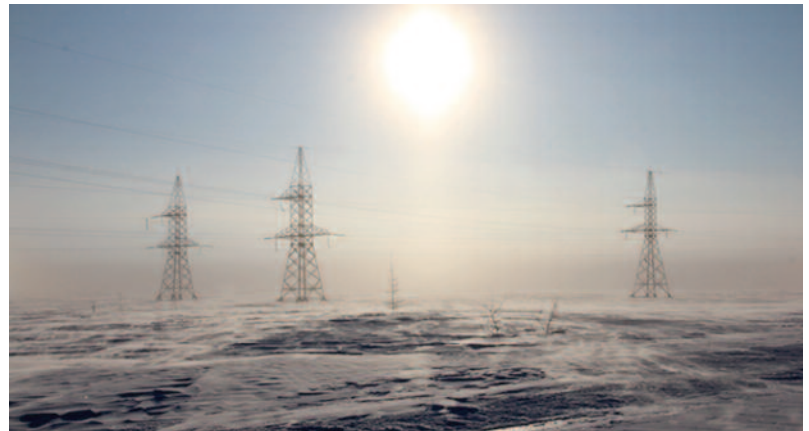
Мочварни терен округа Јамал отежава спровођење радова на ремонту мреже, што зимске услове ставља у први план за спровођење ремонтних радова
