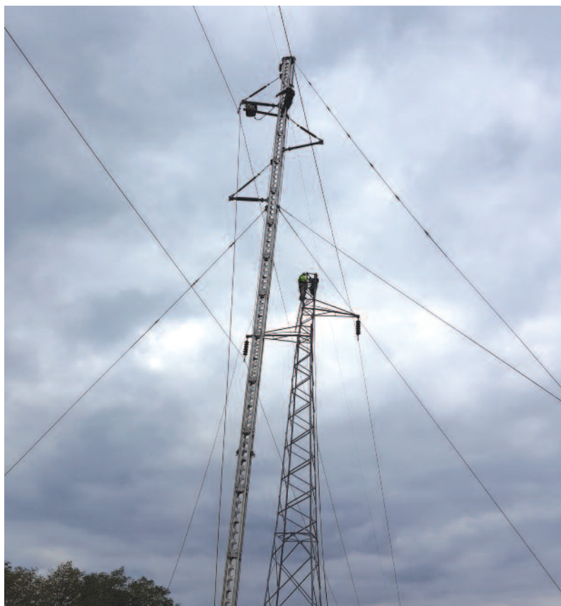
Монтажа сегмената привременог хаваријског стуба
