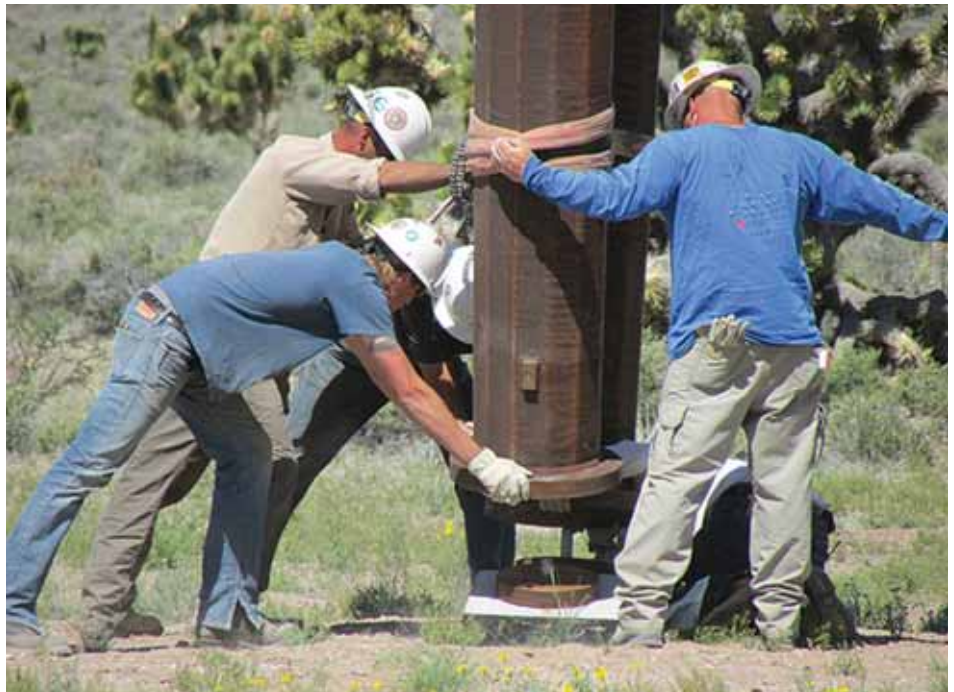
Захваљујући конструкцији која користи подешену силу затезања затега (која делује надоле), стубне конструкције далековода ON Line ослањају се само на конвексне плоче које су фиксиране са две 6-инчне болце које улазе у отворе на доњим деловима две ноге стуба.
