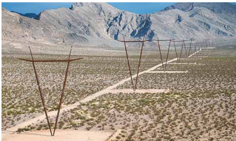
Стубови на On Line далеководу имају приметно мало површинско заузимање околине, у коју се утапа мала преформирана бетонска основа и четири анкера за затег
