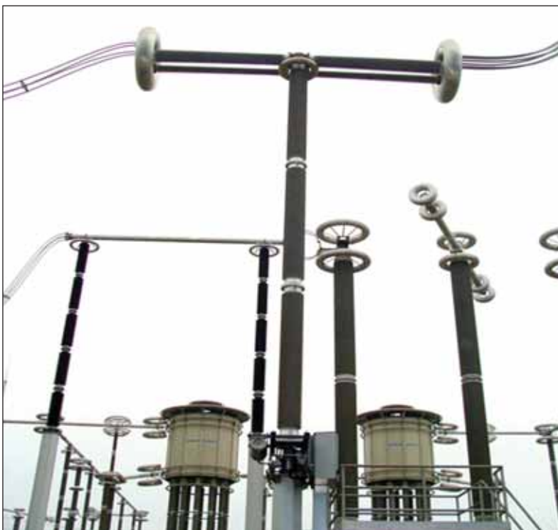
Склопке за премошћавање у конверторској станици Суйдонг
