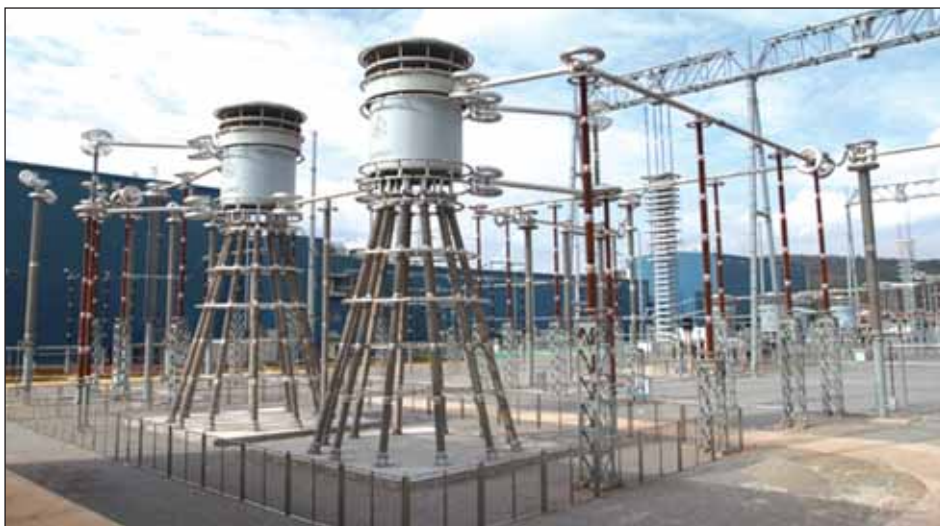
ЈС поље и пригушнице за филтрирање напона у отпремној станици (Хуксионг)
