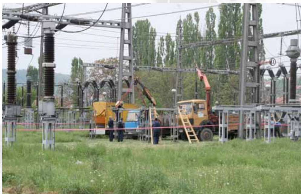
ПД Електроисток Изградња у реконструкцији ТС Београд 8
