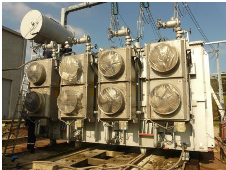
Замена трансформатора на ТС Београд 3
