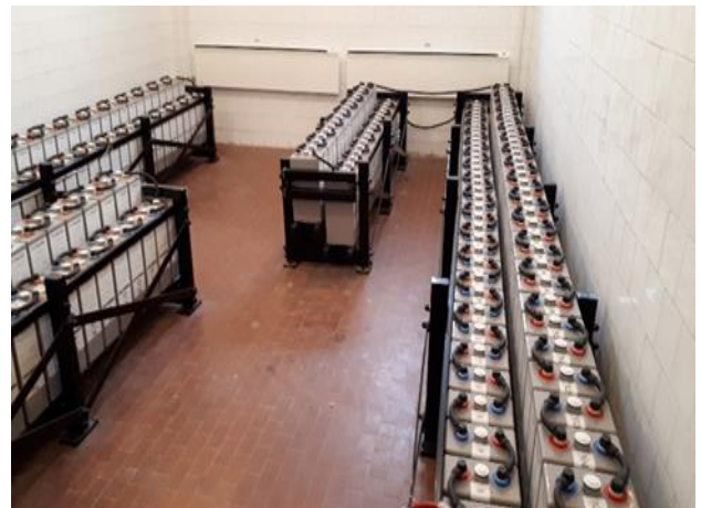
Дизел електрични агрегат и акумулаторске батерије у ТС 400/220/110 kV Сремска Митровица 2
