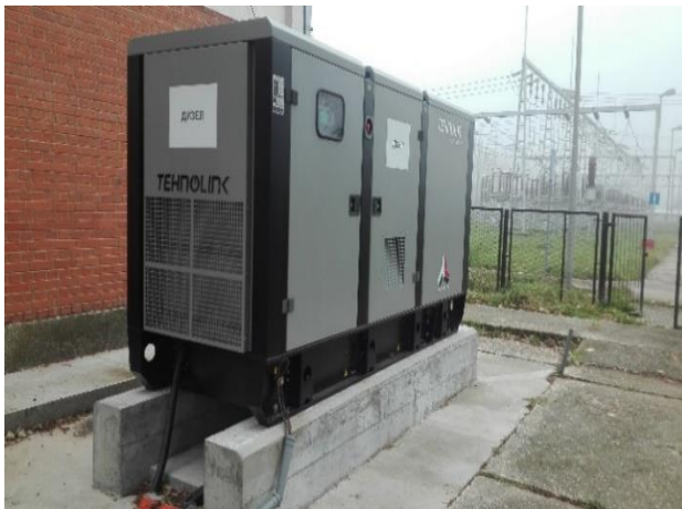
Дизел електрични агрегат и акумулаторске батерије у ТС 400/220/110 kV Сремска Митровица 2
