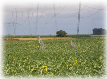
Хаварија на ДВ 110 kV бр. 1012/1 ТС Бајмок – ТС Сомбор 3
