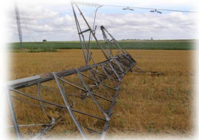
Хаварија на ДВ 110 kV бр. 1012/1 ТС Бајмок – ТС Сомбор 3
